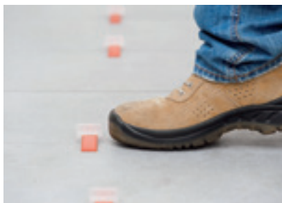
④モルタルが硬化したらクリップを横から取り外してください
