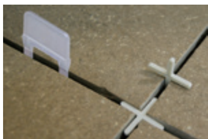
②クリップの上にタイルを置き目地ピッチを入れ、目地幅を均一にさせます。
