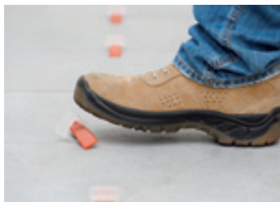
④モルタルが硬化したらクリップを横から取り外してください
