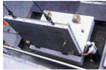
〔躯体へのファスナーによるPC板取り付け図〕
