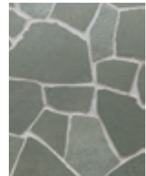
このように形状を整え、目地幅をつめた張り方すると、使用量が 20～30%増えます。
