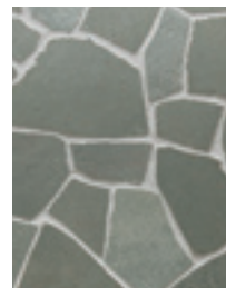
このように形状を整え、目地幅をつめた張り方すると、使用量が 20～30%増えます。
