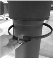
シングル煙突から二重断熱煙突に変わる接続（アダプター）を外すため、ロッキングバンドを外します。
