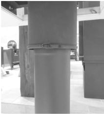
煙突とストーブ本体を接続しているビスを外します。
